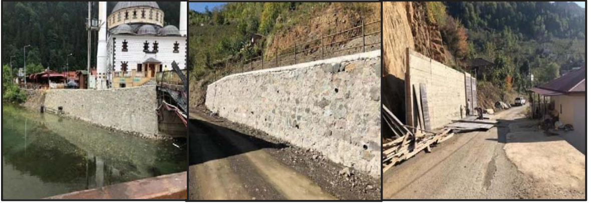
Şekil 1.25: Trabzon İli, Çaykara, Akçaabat ve Maçka İlçelerinde Heyelan Önleyici İstinat Duvarları. (AFAD Trabzon, 2021)
