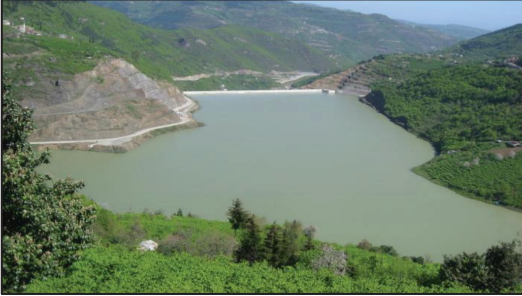
Şekil 1.8: Trabzon İli Atasu Barajı ve HES İnşaatının Genel Görünümü. (DSİ 22. Bölge Müdürlüğü, 2021)
