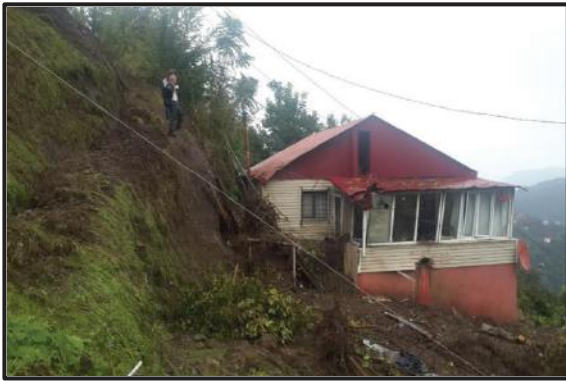
Şekil 1.21: Derin Kayma Yüzeyle Heyelan Örneği (Beşikdüzü Ardıçatak ve Ağaçlı Mahalleri 21.09.2016). (AFAD Trabzon, 2021)
