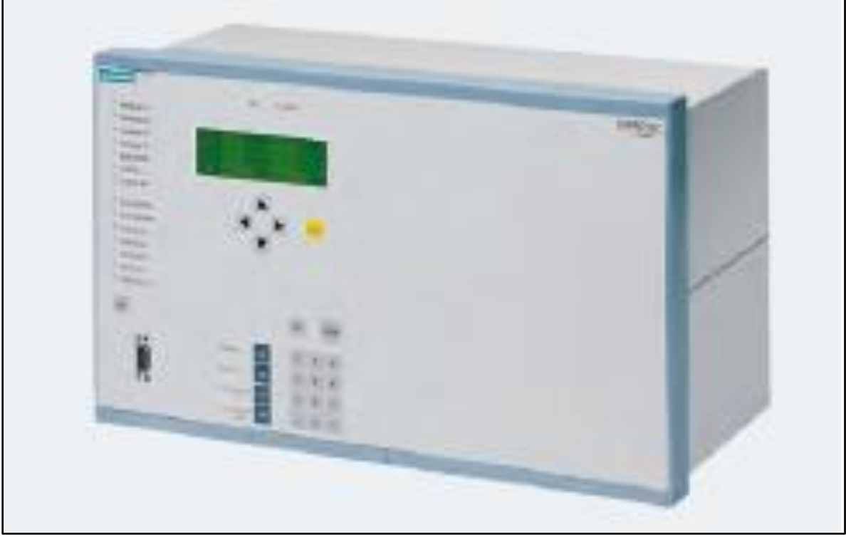
Resim 1 : Siemens Marka 7SA612 model mesafe koruma rölesi.
