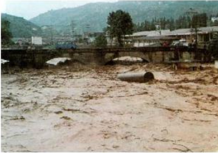
Trabzon-Değirmendere Nemlioğlu Köprüsü, 22 Haziran, 1990.
