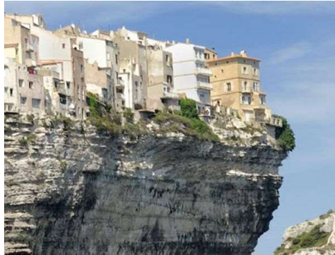
Doğal dokunun korunmaması
