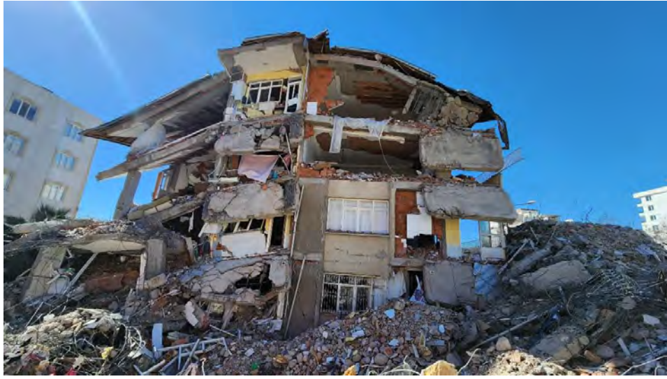
Şekil 74. Yapısal düzensizliklere örnek görseller
