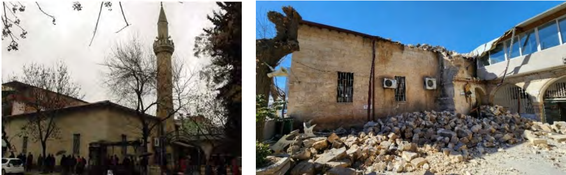
Şekil 146. Eskişaray Cami’nin deprem öncesi (URL-10) ve deprem sonrası görüntüsü
