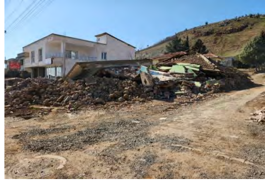
Şekil 82. Bağlayıcı malzeme olarak çamur harcı kullanılmış bazı yığma binalar (Kahramanmaraş İli, Adıyaman İli ve Gaziantep İli, İslahiye İlçesi)
