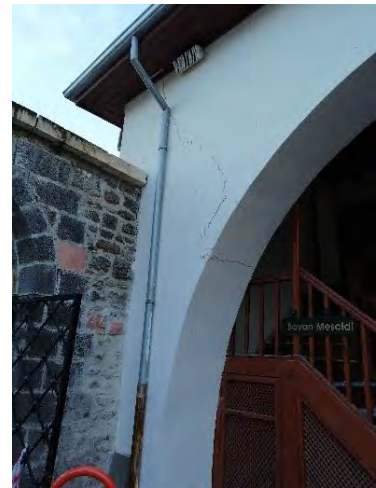
Şekil 149. Düzlem içi etkilerden kaynaklı diyagonal çekme çatlakları
