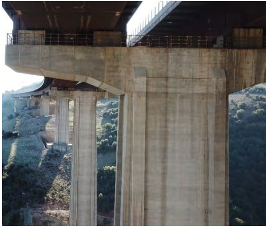
Şekil 117. Deprem takozu hasarlarına ait örnekler
