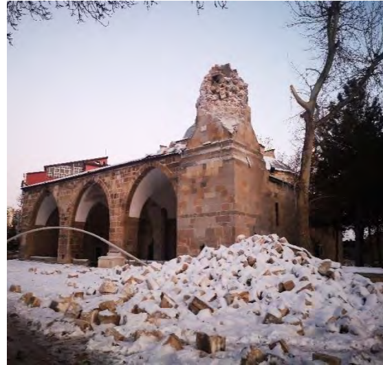
Şekil 143. Elbistan Ulu Cami deprem öncesi (URL-8) ve deprem sonrası minare göçmesi
