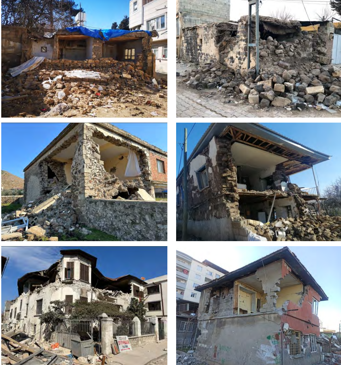
Şekil 93. Düzlem dışı kuvvetlerden kaynaklı bazı yığma bina duvarlarda meydana gelen hasarlar (Adıyaman İli, Gaziantep İli İslahiye İlçesi, Hatay İli ve Kahramanmaraş İli)
