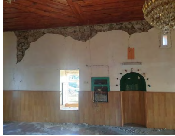
Şekil 178. Yığma cami taşıyıcı duvarlarında oluşan hasarlar
