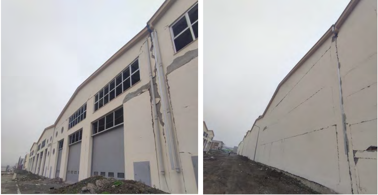
Şekil 103. Yerinde döküm betonarme sanayi yapıları (Kahramanmaraş)
