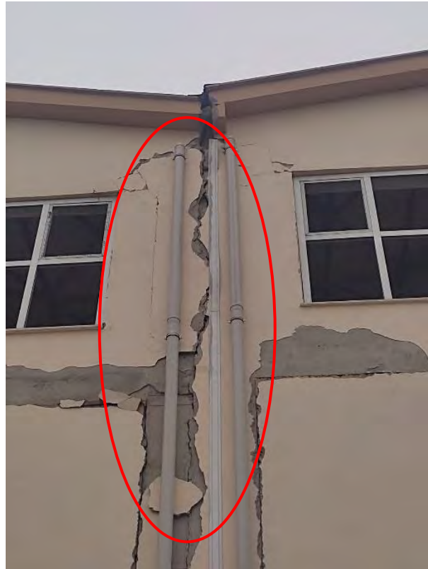
Şekil 104. Bitişik nizamda tasarlanmış betonarme sanayi yapıları (Kahramanmaraş)
