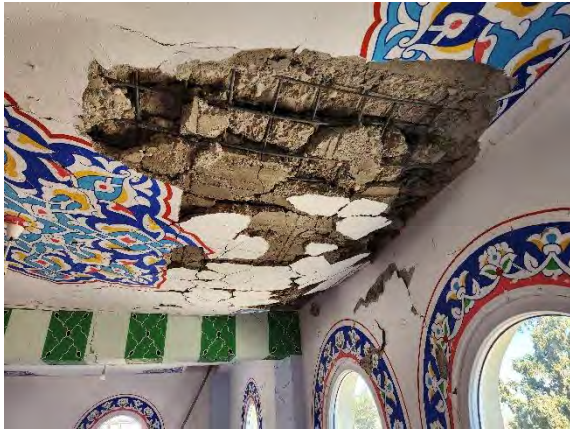
Şekil 172. Betonarme camilerde gözlemlenen döşeme hasarları
