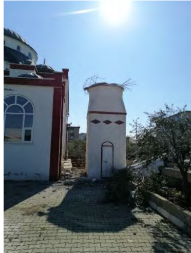
Şekil 182. Betonarme minarenin geçiş kesiti ile gövde arasındaki dayanımın yeterli olmaması durumu
