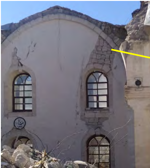
Şekil 139. Adıyaman Ulu Cami duvarında tespit edilen güçlendirme çalışması
