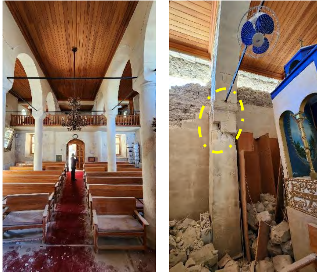
Şekil 136. Kemerlerde gergi elemanı kullanımı, kemerin oturduğu ayakta oluşan hasar
