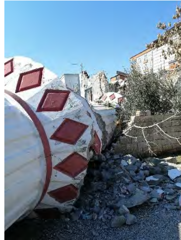
Şekil 182. Betonarme minarenin geçiş kesiti ile gövde arasındaki dayanımın yeterli olmaması durumu
