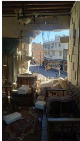
Şekil 157. Düzlem dışı etkilerden kaynaklı hasar ve göçmeler
