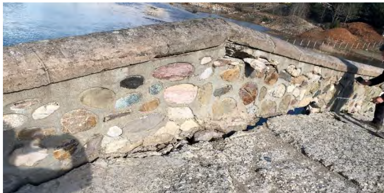
Şekil 128. Ceyhan (Taş) Köprüsü
