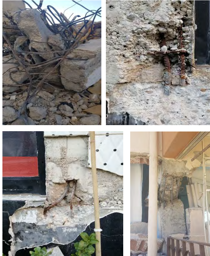
Şekil 77. Nervürsüz donatı ve korozyonun etkilediği duruma ait görseller
