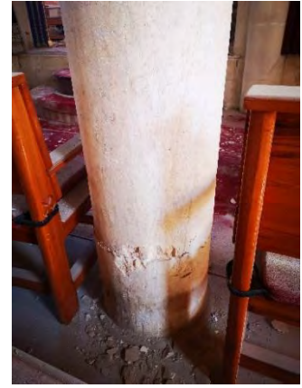
Şekil 132. Düzlem dışı etkilerden kaynaklı taşıyıcı duvarlarda oluşan hasarlar
