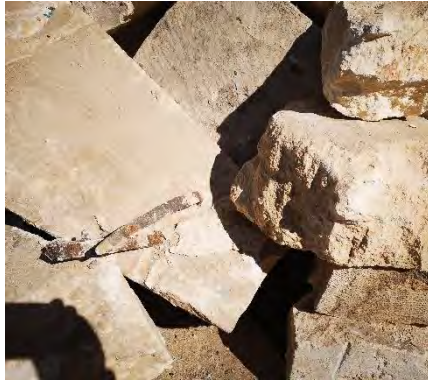
Şekil 138. Adıyaman Ulu Cami minaresinde kullanılan kenetler
