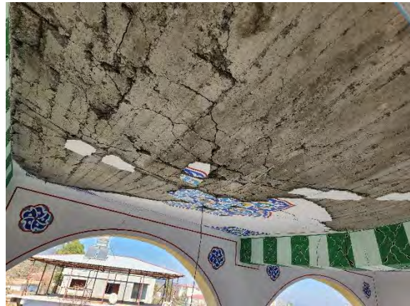
Şekil 172. Betonarme camilerde gözlemlenen döşeme hasarları
