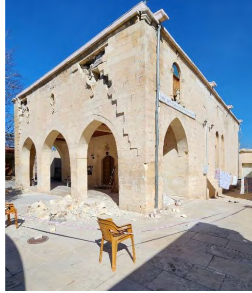
Şekil 131. Adıyaman Mor Petrus Kilisesi deprem öncesi (URL-6) ve deprem sonrası düzlem içi etkilerden kaynaklı hasar
