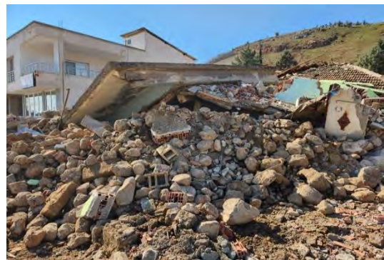
Şekil 83. Yığma duvar inşasında kullanılan pürüzsüz ve şekilsiz (keskin köşelere sahip) moloz taşlar (Kahramanmaraş İli ve Gaziantep İli, İslahiye İlçesi)
