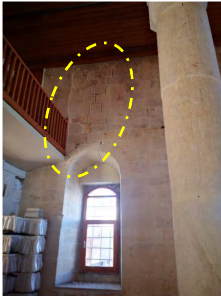
Şekil 134. Düzlem içi etkilerden kaynaklı diyagonal çekme çatlakları
