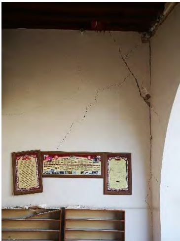
Şekil 149. Düzlem içi etkilerden kaynaklı diyagonal çekme çatlakları
