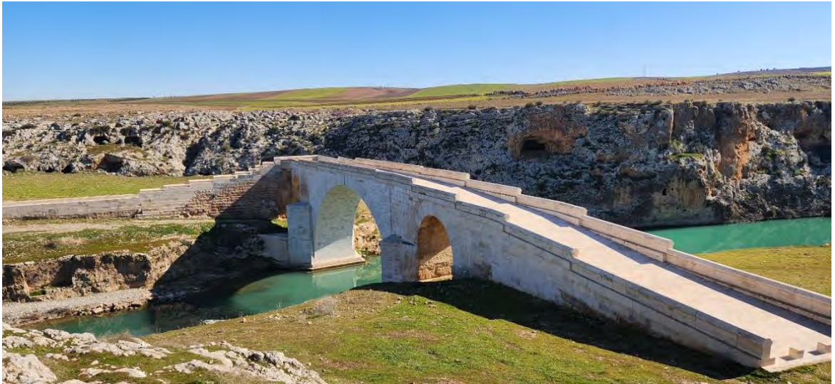
Şekil 126. Kızılin (Sıngas) Köprüsü
