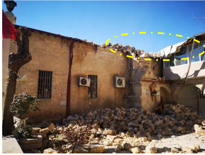
Şekil 147. Adıyaman Eskişaray Cami minare ve çatı hasarları
