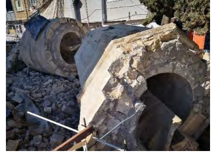
Şekil 137. Adıyaman Ulu Cami deprem öncesi (URL-6) deprem sonrası cami ve minare göçmesi
