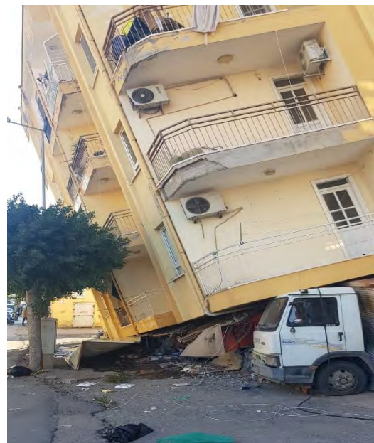
Şekil 76. Yumuşak kat durumuna ait örnek görseller
