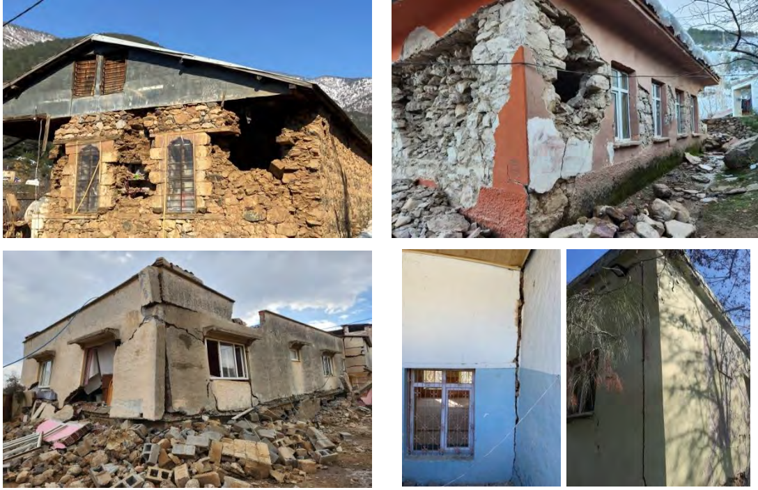
Şekil 94. Düzlem dışı kuvvetlerden kaynaklı bazı yığma binalarda meydana gelen köşe hasarları (Gaziantep İli, İslahiye İlçesi)
