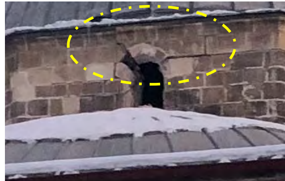
Şekil 144. Cami kubbesindeki pencere kenarlarında oluşan hasarlar
