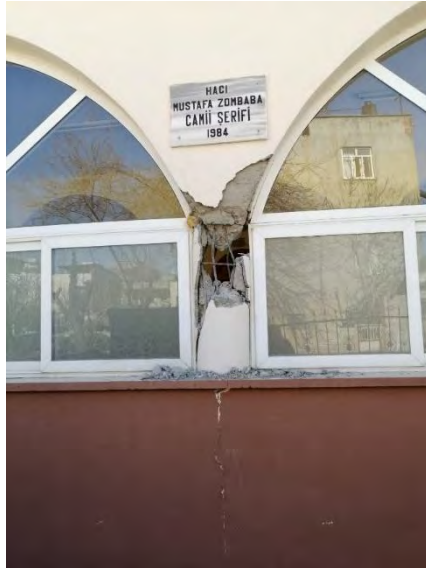
Şekil 171. Betonarme camilerde gözlemlenen kısa kolon hasarları
