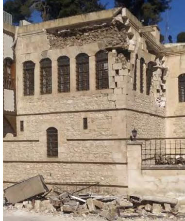
Şekil 157. Düzlem dışı etkilerden kaynaklı hasar ve göçmeler
