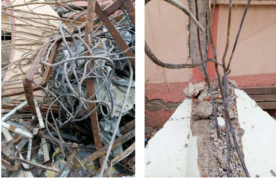
Şekil 175. Betonarme camilerde gözlemlenen nervürsüz donatılar
