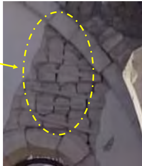
Şekil 139. Adıyaman Ulu Cami duvarında tespit edilen güçlendirme çalışması
