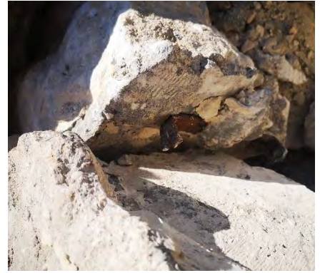
Şekil 138. Adıyaman Ulu Cami minaresinde kullanılan kenetler
