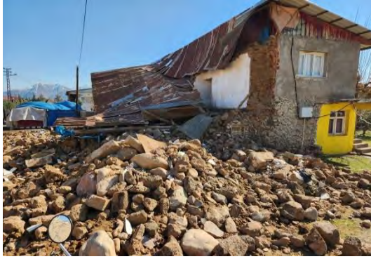
Şekil 82. Bağlayıcı malzeme olarak çamur harcı kullanılmış bazı yığma binalar (Kahramanmaraş İli, Adıyaman İli ve Gaziantep İli, İslahiye İlçesi)
