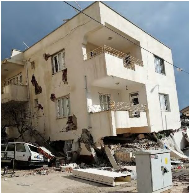
Şekil 76. Yumuşak kat durumuna ait örnek görseller
