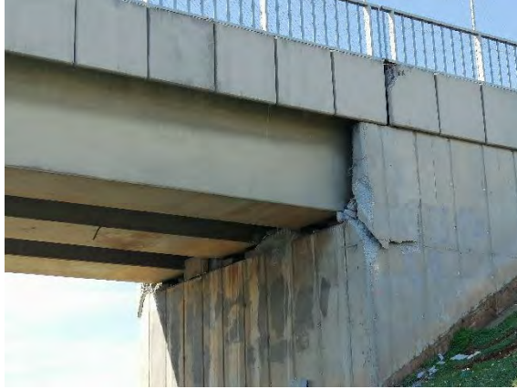
Şekil 117. Deprem takozu hasarlarına ait örnekler
