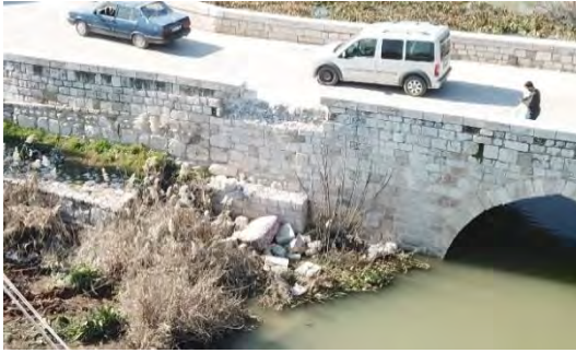
Şekil 121. Hatay ilinde bulunan tarihi bir köprüye ait hasarlar
