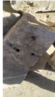
Şekil 141. Adıyaman Yenipınar Cami minaresi göçmesi ve kullanılan zıvana ve kenet örnekleri
