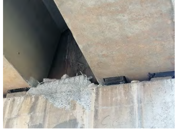
Şekil 117. Deprem takozu hasarlarına ait örnekler
