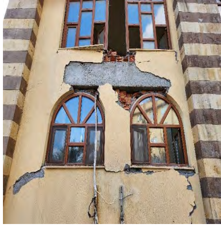
Şekil 173. Betonarme camilerde gözlemlenen bölme duvar hasarları
