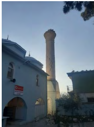
Şekil 187. Petek bölümünde tespit edilen hasarlar
