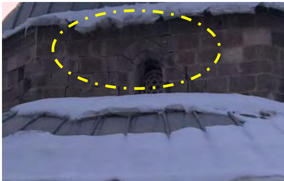
Şekil 144. Cami kubbesindeki pencere kenarlarında oluşan hasarlar
