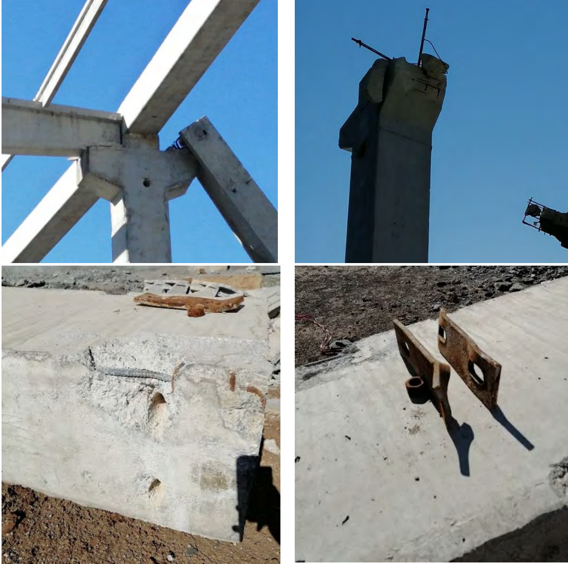
Şekil 110. Yetersiz bağlantı ve ekipmanları
