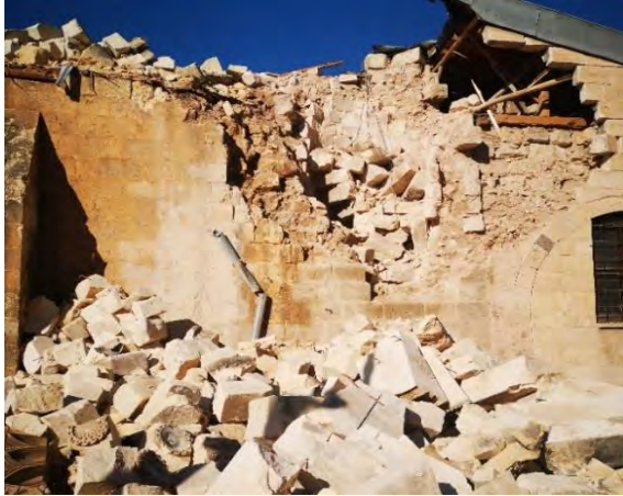
Şekil 178. Yığma cami taşıyıcı duvarlarında oluşan hasarlar
