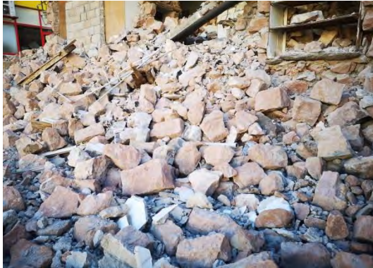
Şekil 82. Bağlayıcı malzeme olarak çamur harcı kullanılmış bazı yığma binalar (Kahramanmaraş İli, Adıyaman İli ve Gaziantep İli, İslahiye İlçesi)
