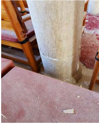
Şekil 132. Düzlem dışı etkilerden kaynaklı taşıyıcı duvarlarda oluşan hasarlar
