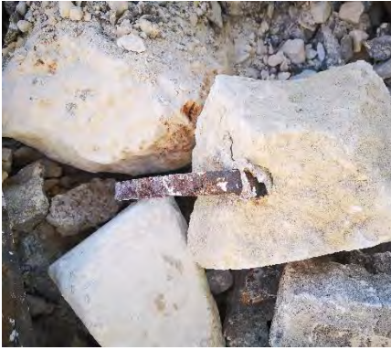
Şekil 138. Adıyaman Ulu Cami minaresinde kullanılan kenetler
