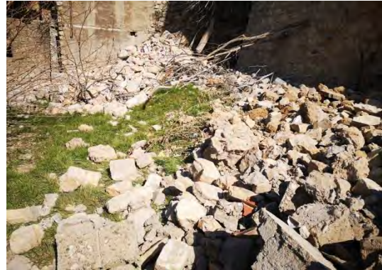
Şekil 82. Bağlayıcı malzeme olarak çamur harcı kullanılmış bazı yığma binalar (Kahramanmaraş İli, Adıyaman İli ve Gaziantep İli, İslahiye İlçesi)
