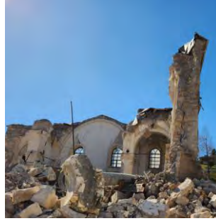
Şekil 137. Adıyaman Ulu Cami deprem öncesi (URL-6) deprem sonrası cami ve minare göçmesi
