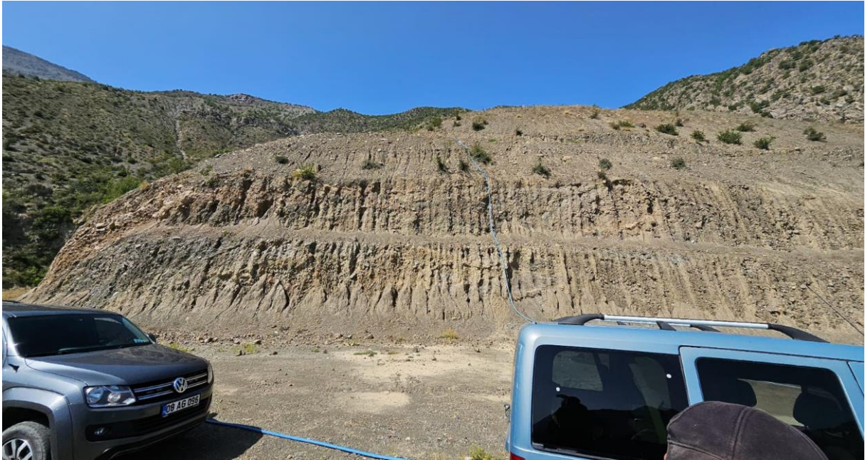
Şekil 6. Çalışma sahasındaki kazılarda palyelendirilen ve kalınlığı 10 metreyi aşan yamaç molozlarını
