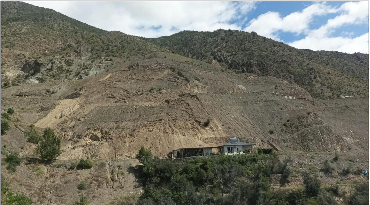
Şekil 3. Kazı alanında 31.07.2024 tarihinde meydana gelen heyelan
