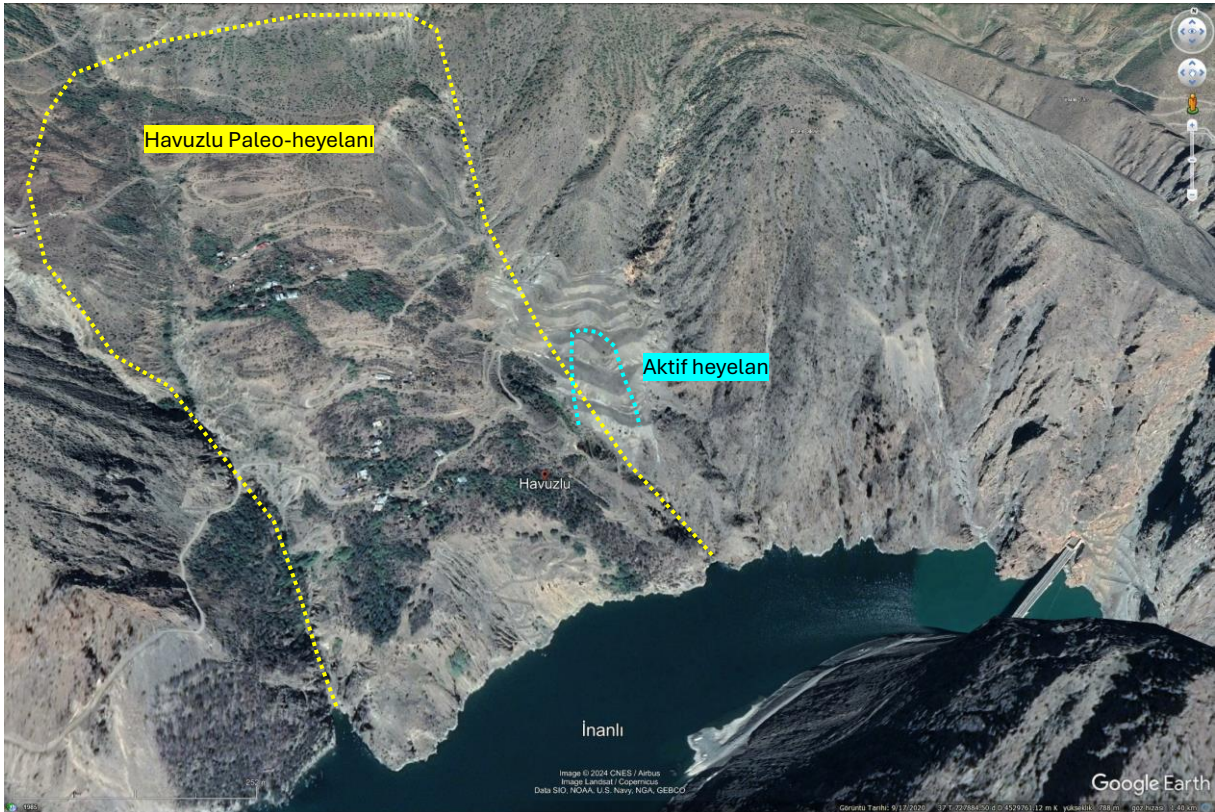
Şekil 2. Havuzlu Paleo-heyelanının Google Earth uydu görüntüsündeki konumu ve 12.12.1222 tarihinde meydana gelen heyelan
