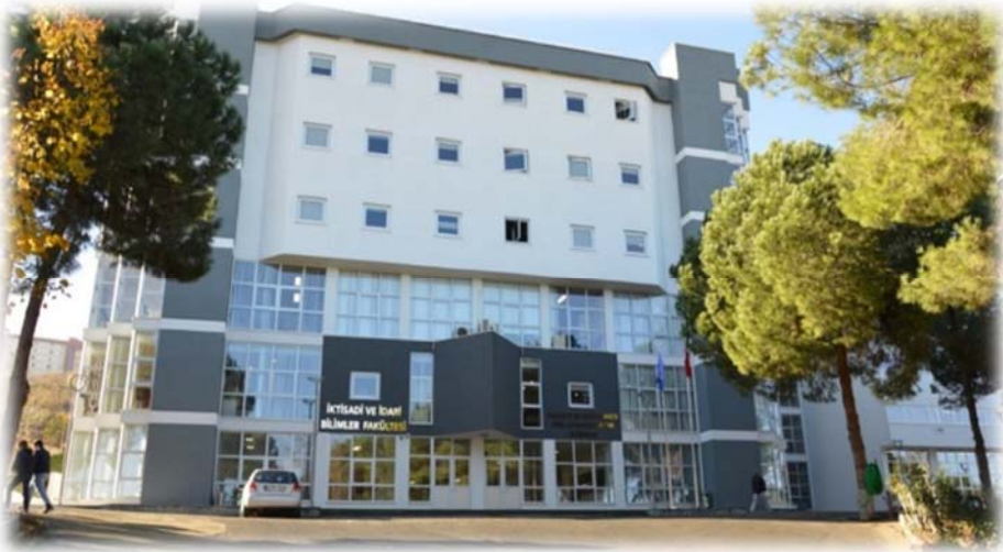
Fakülte Binası İdari Blok
