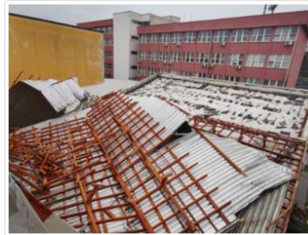
Zarar gören çatıların incelenmesi İşyeri Sağlık ve Güvenlik Birimi, 02.12.2021
