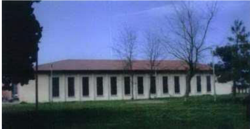
Şekil 10. Toplantı Salonu Binası 61
