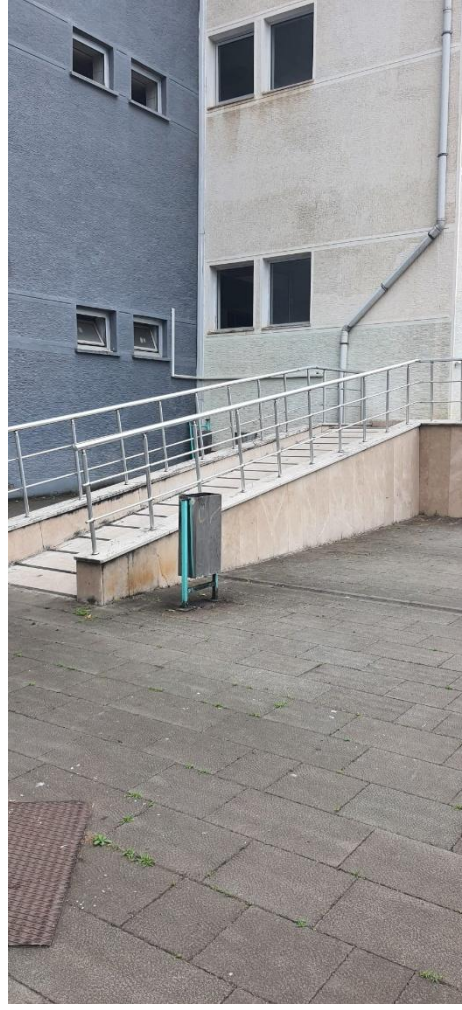
Kantinden bölüme giriş rampası
